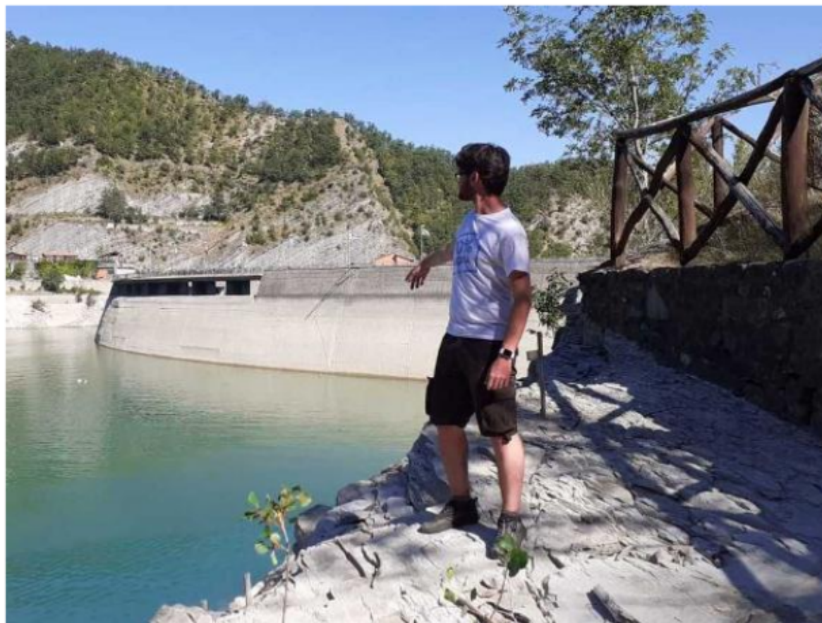
Sopra, l'ottimo livello della diga di Ridracoli e, a destra, il presidente di Romagna Acque - Società delle Fonti, Tonino Bernabè
